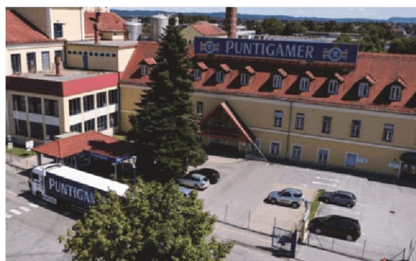
Die Brauerei Puntigam: einzigartiges Energieversorgungskonzept mit Gärwärme.
